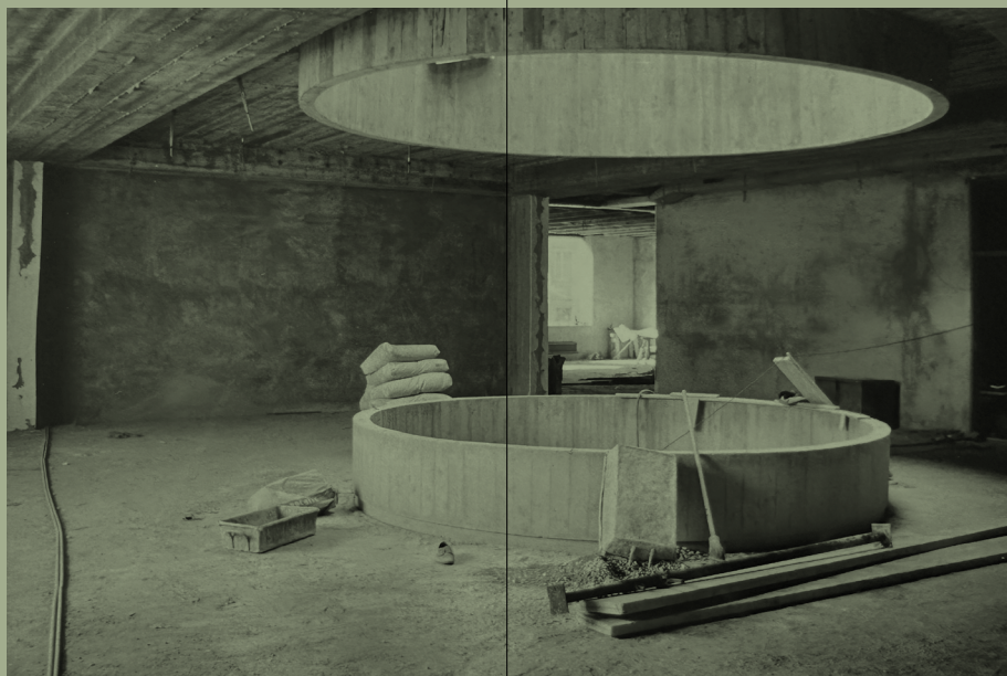
Photo du puits de lumière lors de la construction du Muséum (MHNG) 1963 © georges neri
